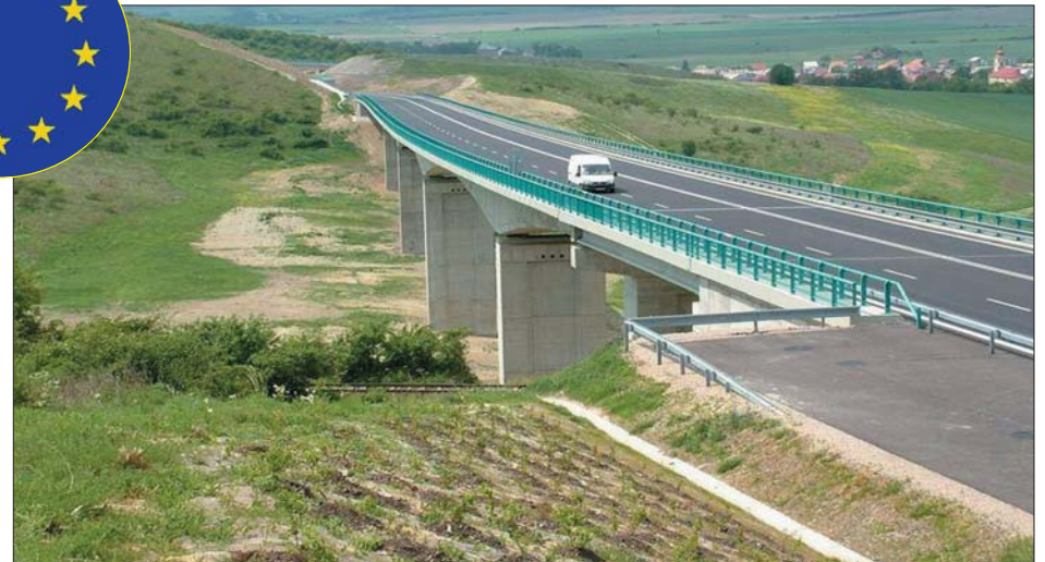
Osgyán fölött 2004. december 4-étől magasodik az új elterelő út hídja.
